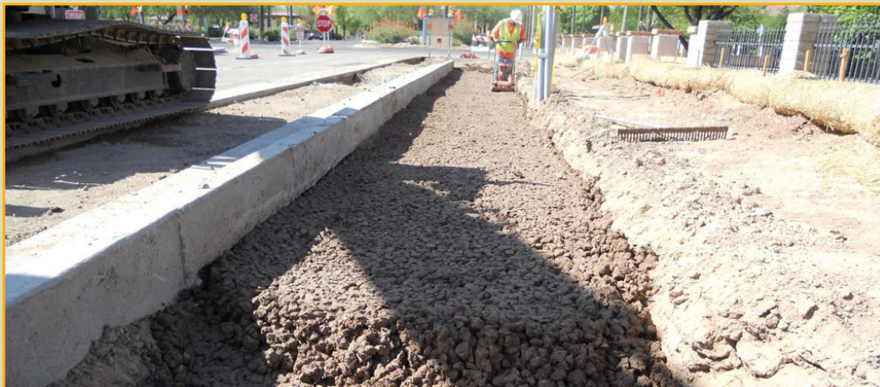
אדמת המבנה CU Soil מיושמת בתעלת גידול רציפה בתת מדרכה
